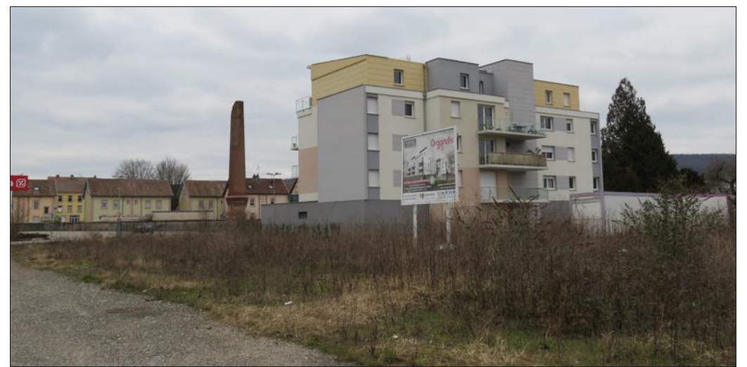
« Nos efforts doivent se concentrer sur la politique du logement », indique Fernand Burkhalter. Annonçant le lancement imminent du second bâtiment d'Ideha sur une parcelle de la Grand Pré. De même que la résidence seniors devrait sortir de terre d'ici quelques semaines.
